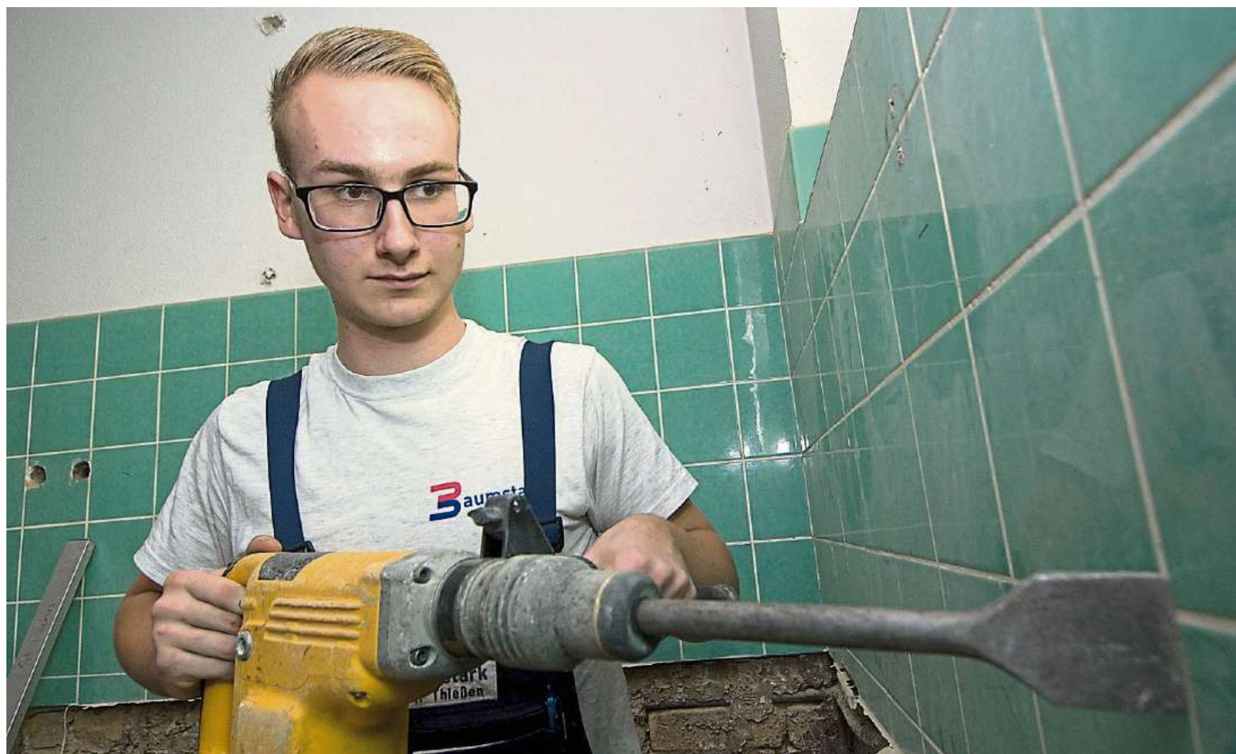
Marcel Thießen ist seit zwei Jahren Auszubildender zum Anlagenmechaniker für Sanitär, Heizungs- und Klimatechnik bei der Firma Baumstark.
